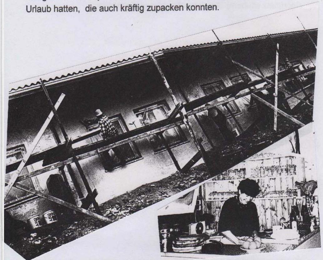
Zwischendurch gab es immer wieder Arbeiten, die sehr zeitaufwendig waren, wie Stromverteiler montieren, Fensterbänke versetzen, Stromkabel verlegen, Fenster schleifen und streichen, Bretter streichen, Gerüst umstellen und vieles mehr.
